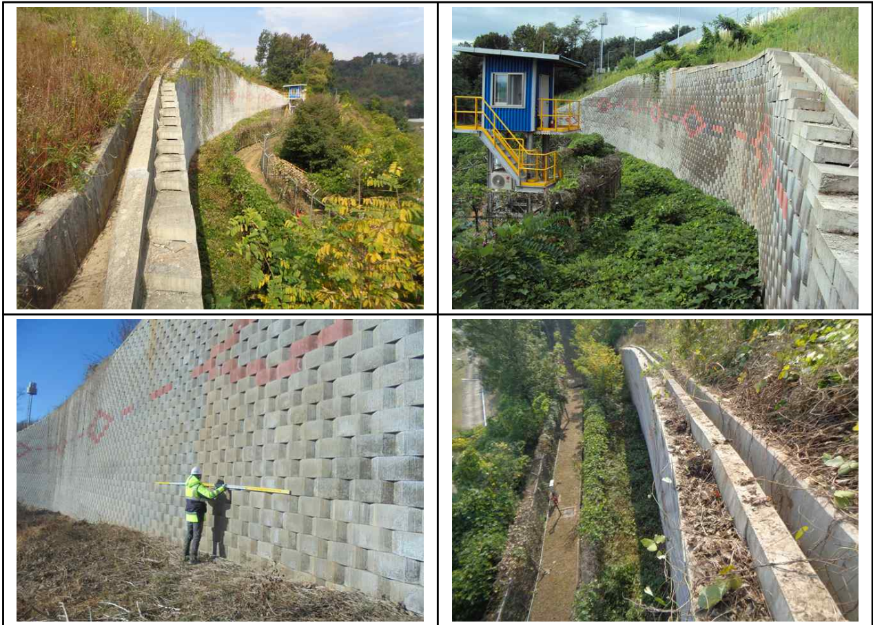
【그림 2.10】 외관조사 전경
