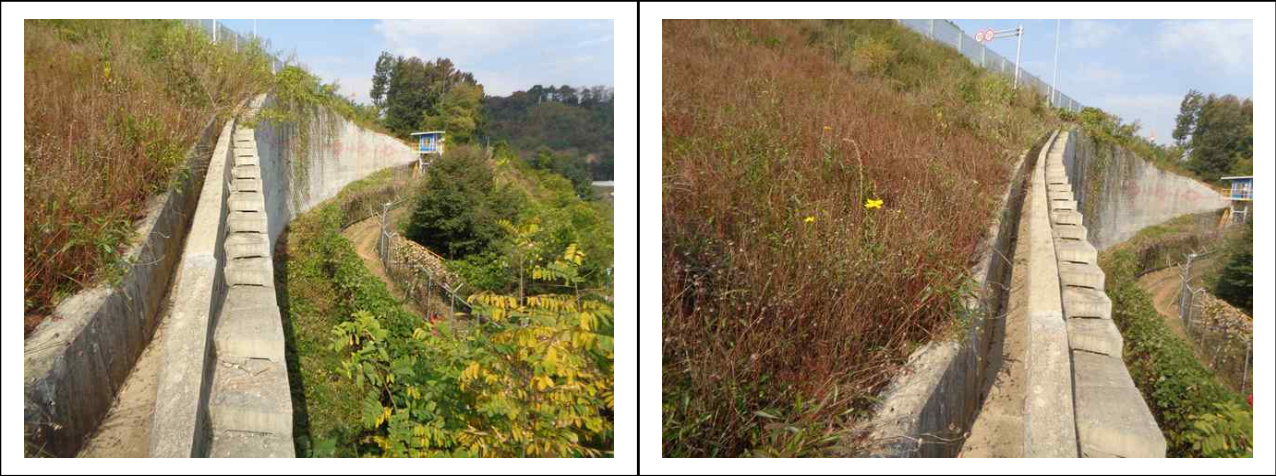
【사진 2.1】 대상옹벽 전경
